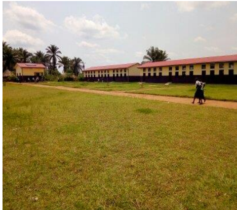
Situation après les travaux
